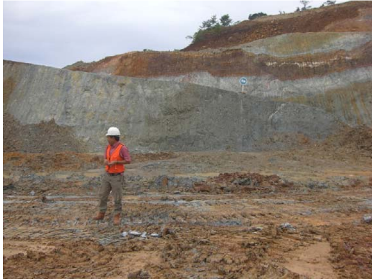
Gambar 73. Permukaan “Work in Process”, Objek Pengukuran Pada Daerah Penggalian.
