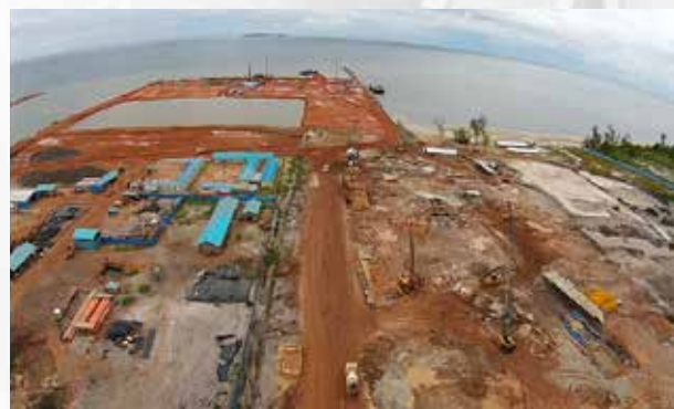
Gambar 3. Progres pembangunan pelabuhan PT. WHW sampai dengan bulan Mei 2015
