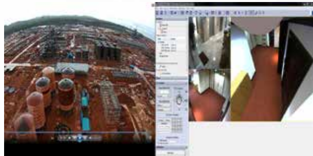
Gambar 1. Progres pembangunan refinery alumina PT. WHW sampai bulan Mei 2015
