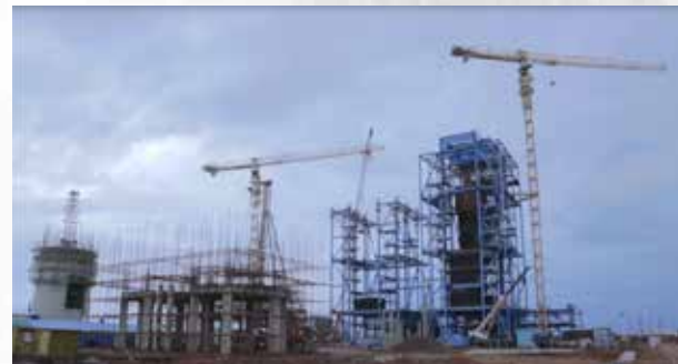
Gambar 2. Progres pembangunan power plant PT. WHW sampai dengan bulan Mei 2015
