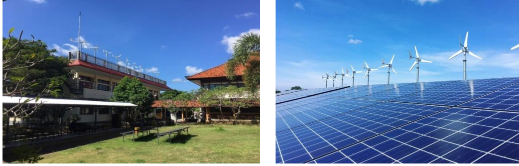
Gambar 2. Pilot Project Smart Grid in Microgrid yang Diimplementasikan di Rooftop Gedung DH Teknik Elektro Fakultas Teknik Universitas Udayana
